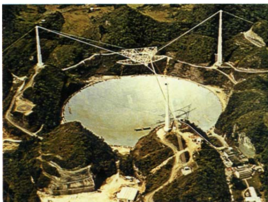
Fig. 3: O gran radiotelescopio de Arecibo (Porto Rico). O colector, de 305m de diámetro, está constituído por 27.000 paneis de aluminio densamente perforados para permitir a drenaxe da auga de choiva. O instrumento está orientado cara ao cént, pero o receptor que, sostido por tres alicerces atópase no foco do colector, pódese desprazar lateralmente para poder observar até unha distancia de 20° do cént. Polas súas grandes dimensións, este instrumento é adecuado para ser utilizado como transmisor en estudos con radar.
