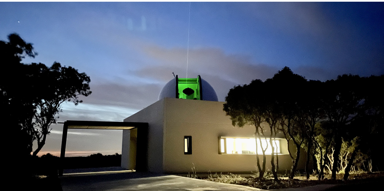
Figura 9. Estación de telemetría láser del Observatorio de Yebes emitiendo pulsos láser en verde.
