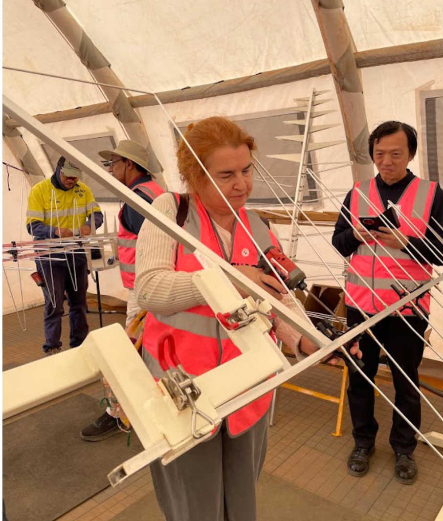
Figura 3. Las antenas dipolo SKA-Low se asemejan a árboles de Navidad metálicos, tanto en apariencia como en tamaño. En la imagen Lourdes Verdes-Montenegro, coordinadora de la participación española en SKA, construye una antena SKA-Low durante una visita al emplazamiento en noviembre de 2025. Crédito: L. Verdes-Montenegro.
