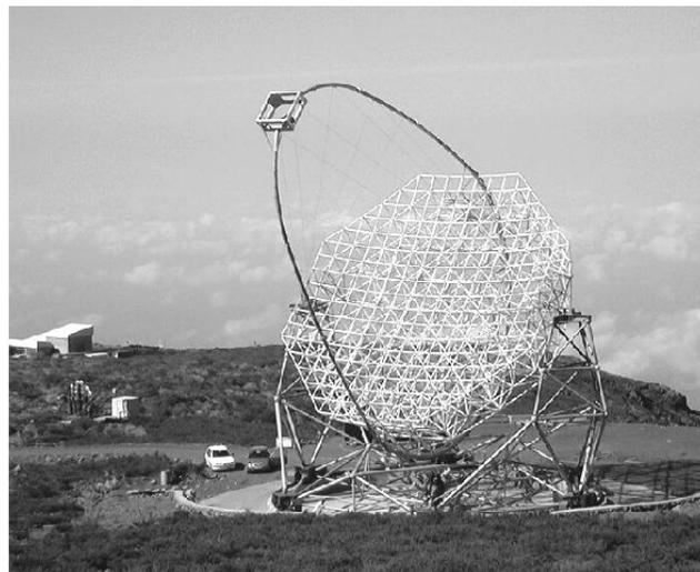
Figura 1: El telescopio MAGIC antes de instalar los espejos (Agosto 2002).
