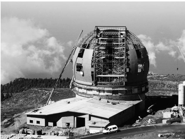
**Fig. 1.** Vista del edificio del GTC en el ORM donde se aprecia el estado de avance en el montaje de la cúpula y el edificio anexo cerrado y cubierto. Fotografía tomada el 13 de noviembre de 2001.
