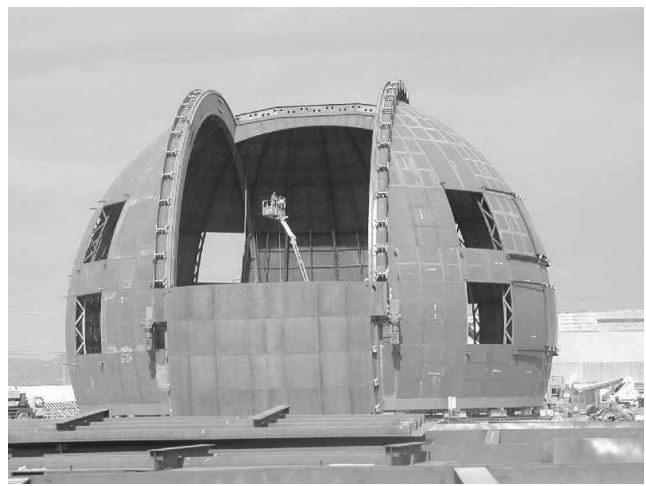
Fig. 1. Vista de la cúpula montada para pruebas en la factoría de Vitoria.
