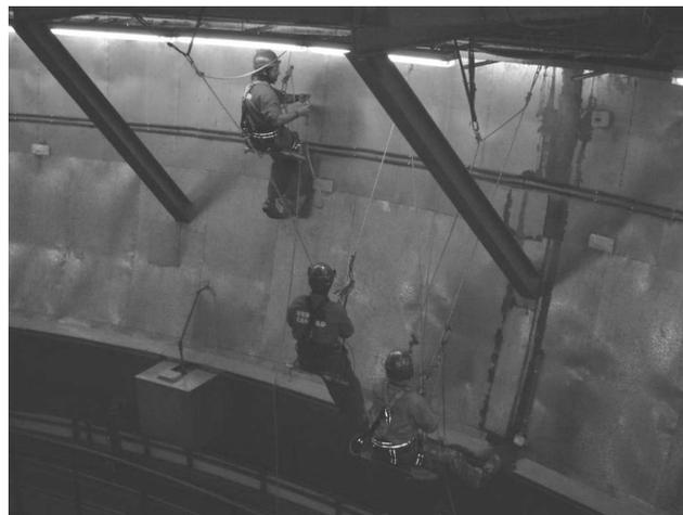
Figura 1 — Trabajadores de Verticalia S.A. limpiando la pared interior de la cúpula.
