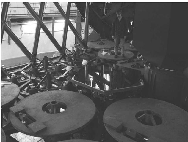
Figura 5 — El primer segmento ya colocado y fijado en su celda. Nótese en primer plano los pesos muertos que se han usado en lugar de los segmentos para equilibrar el telescopio, así como la zona donde se pondrían los próximos segmentos ya liberada de estos pesos muertos.
