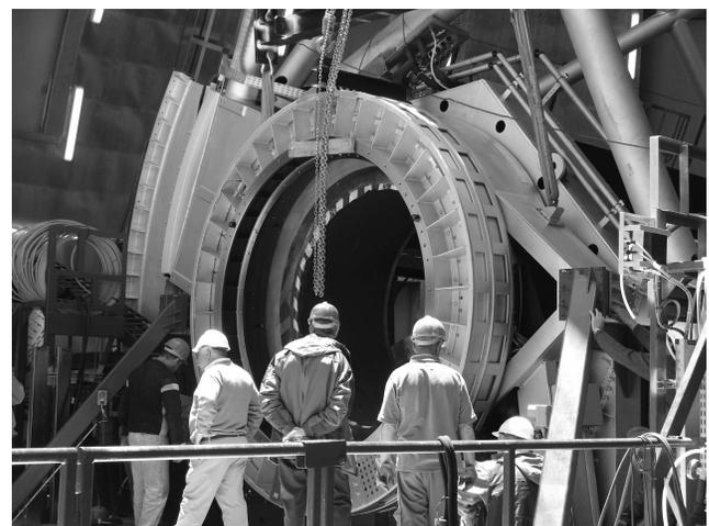
Figura 1 — *Instalación de uno de los rotadores de instrumentos. Ya están instalados los dos rotadores en sendas estaciones focales Nasmyth.*
