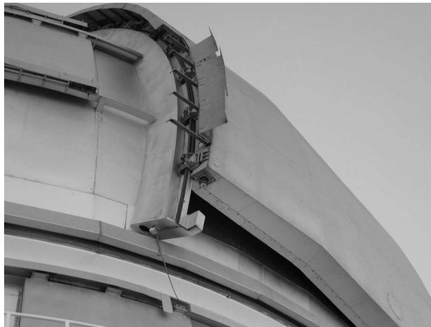
Figura 1 — La compuerta de observación por su parte posterior abierta casi hasta su tope. En esta posición encalló y quedó bloqueada cuando ocurrió la tormenta.
