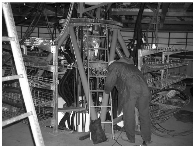
Figura 3 — Vista del rotador de cables de acimut, con gran parte de las conducciones ya ensartadas. Por lo demás, la actividad en torno al telescopio
