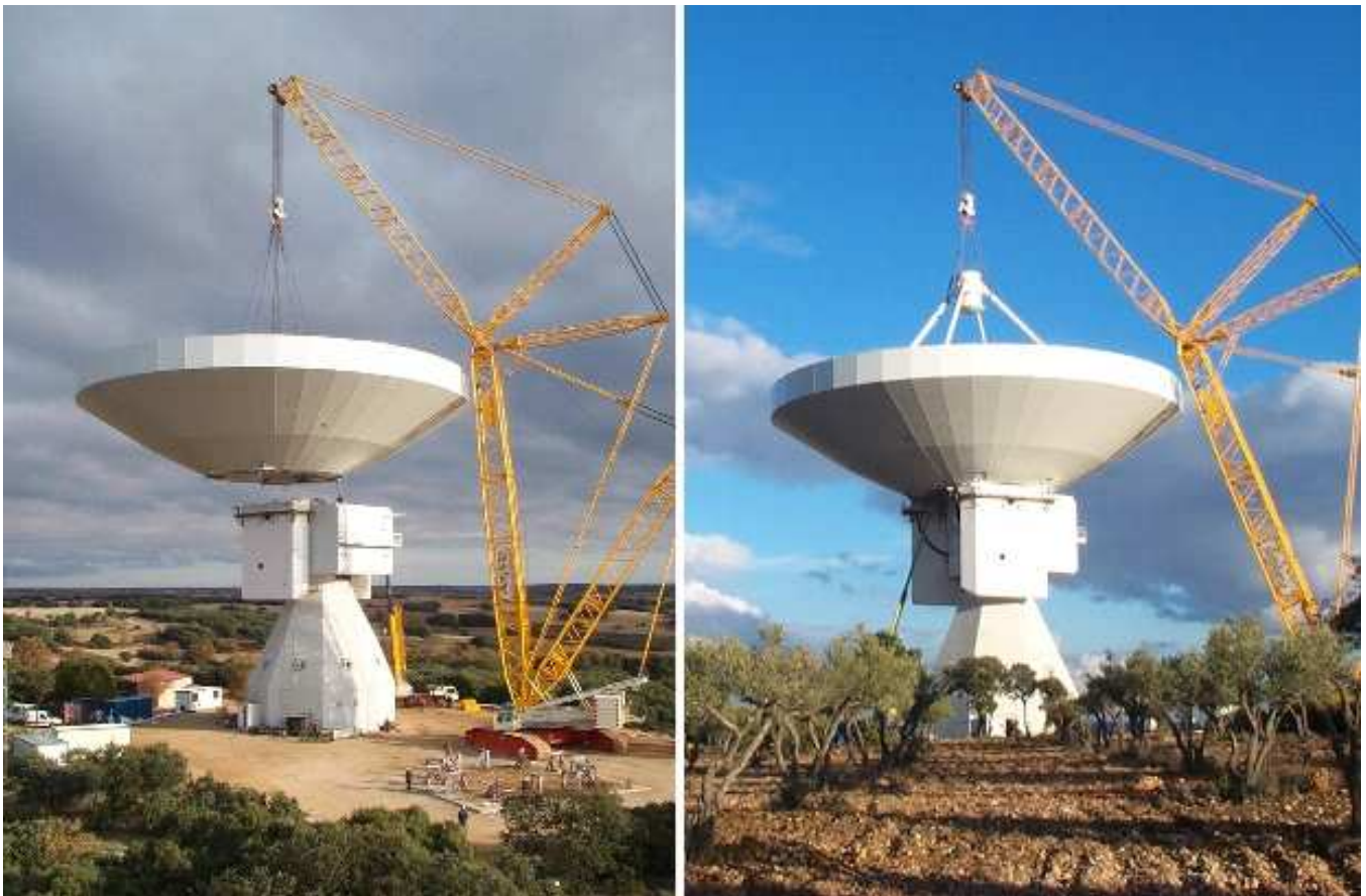
Figure 1 – Izquierda: montaje de la estructura trasera (en un solo bloque) sobre el yugo de la antena. Derecha: montaje del cuadrupodo del reflector secundario.
