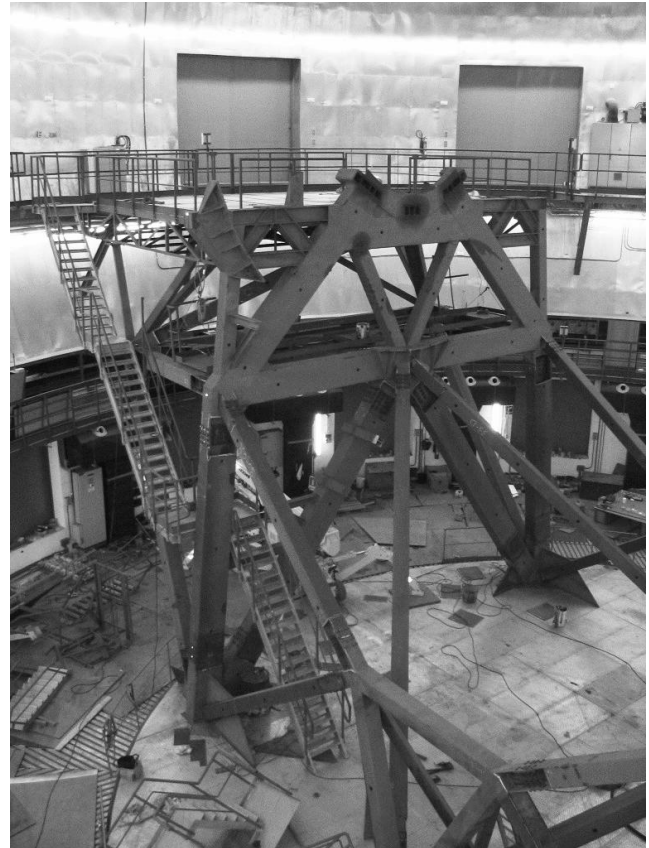
Fig. 1.: La plataforma Nasmyth B durante su montaje
