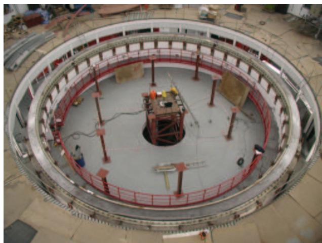
Fig. 1.: El anillo de acimut sobre el pilar del telescopio
